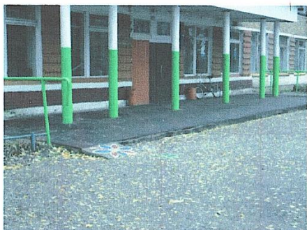
Фото № 5 Площадка при входе здание
