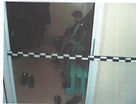
Фото № 52 Дверной проем раздевалки спортзала меньше 90 см.
