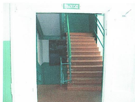
Фото № 26 лестничные клетки.
