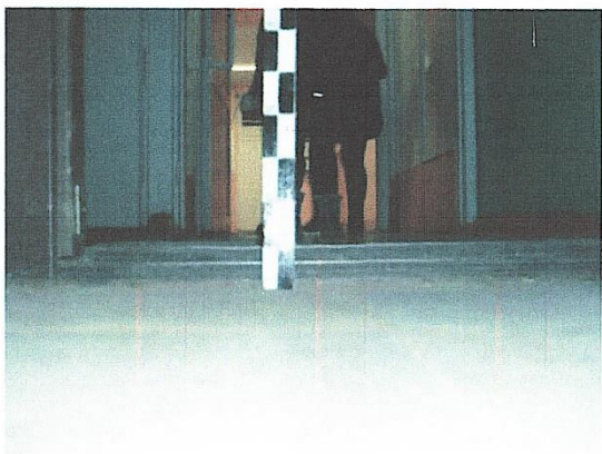
Фото №29 Ненормативный порог на входных дверях. № 1
