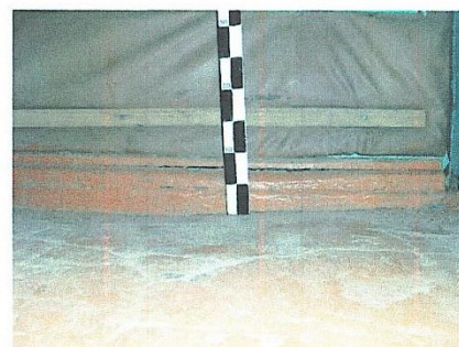
Фото №22 Запасный выход пороги выше норматива до 10см.
