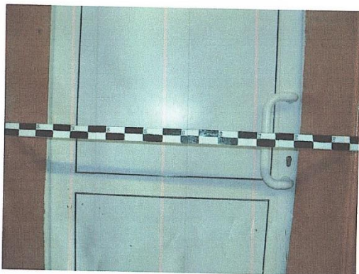
Фото № 59 Входные (эвакуационные) двери № 4
