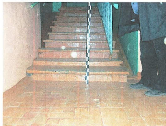
Фото №22 Запасный выход пороги выше норматива до 10см.
