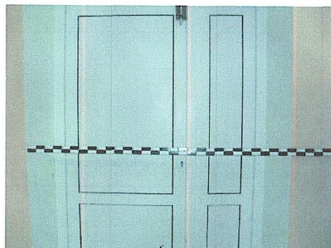
Фото № 57 Входные (эвакуационные) двери № 3
